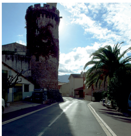
Travaux de réfection
