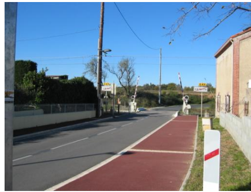
RD 49 A U FRANCHISSEMENT SNCF
